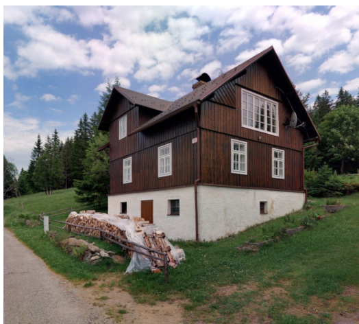
Dům č.p. 164 pohled na polozapuštěné PP
