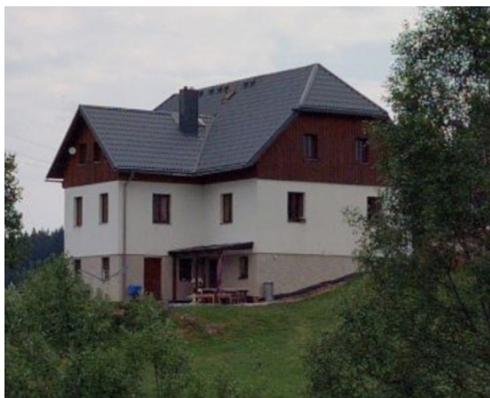
Dům č.p. 45 pohled na polozapuštěné PP
