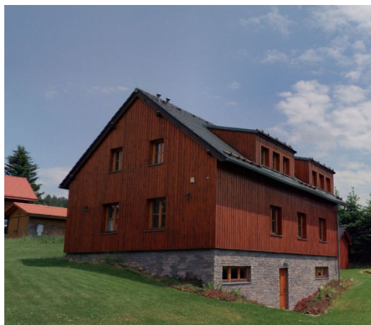
Dům č.p. 153 pohled na polozapuštěné PP
