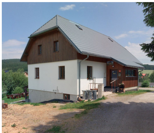
Dům č.p. 45 pohled na NP se vstupem
