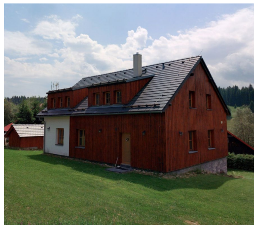
Dům č.p. 153 pohled na NP se vstupem
